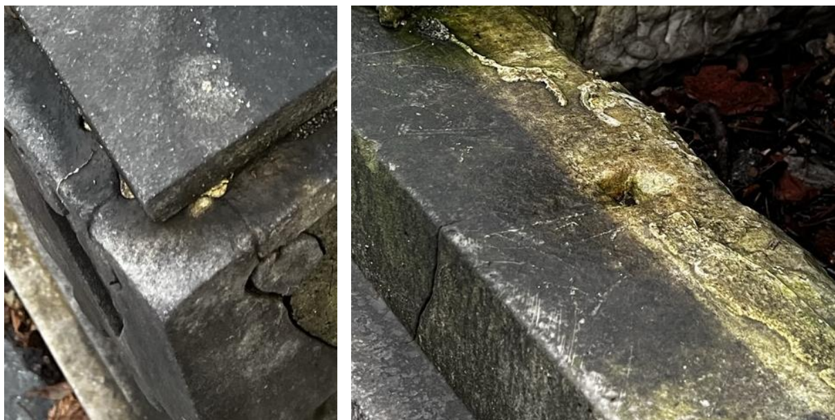
Skader som trolig skyldes rustsprengning
